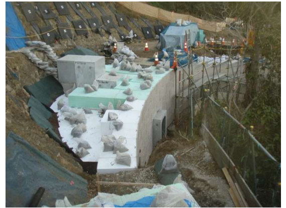
(E P S 施工状況)
