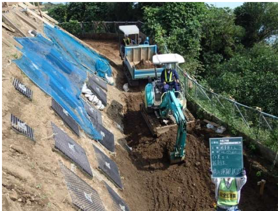
(土工施工状況)
