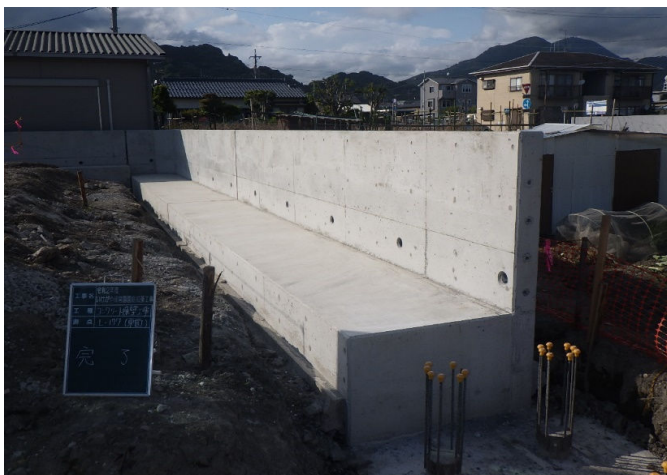
L型擁壁完了時写真
