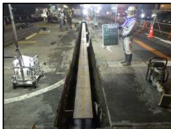
写真-5 受桁設置
