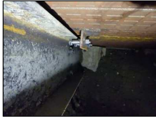
写真-8 端部浮上防止対策設置
