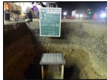
写真-3 プレート設置
