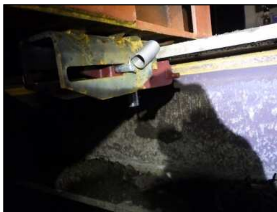
写真－６ スライドロック取付け状況
