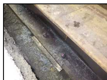
写真-6 受桁ボルト固定
