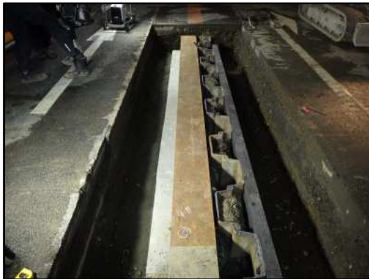
写真-7 端部敷桁設置
