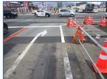
写真-9 覆工板開放状況
