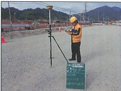
写真-5 GNSSによる出来形計測
