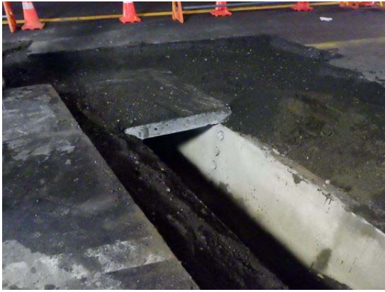
写真－5 頂版取壊し完了
