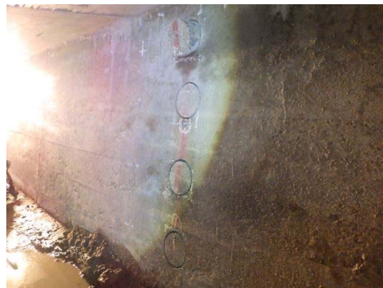
写真-2 コアカッター施工完了
