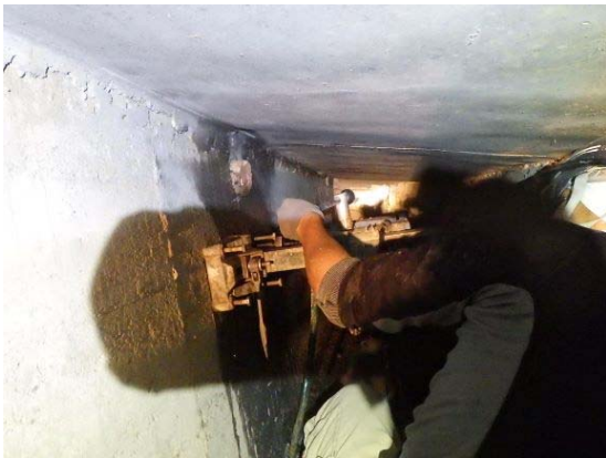
写真-1 コアカッター施工状況
