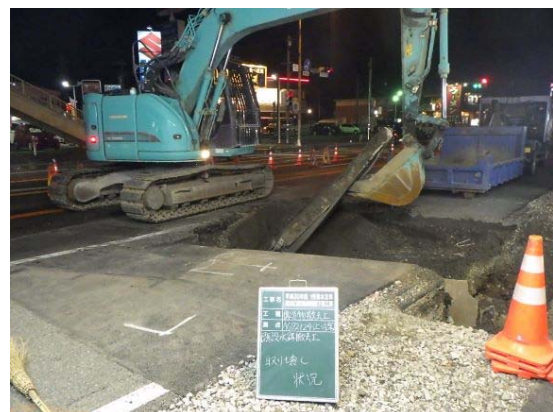
写真-4 頂版取壊し
