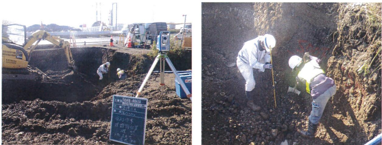
写真 5.6 自動追尾型 TS による埋設物確認
