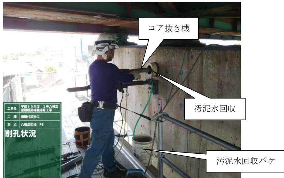
アンカー削孔状況（コア抜き機使用）
