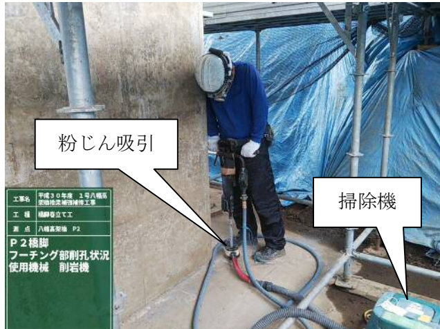
アンカー削孔状況（削岩機使用）
