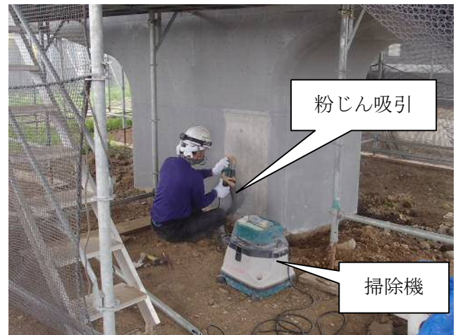
既設構造物ケレン状況
