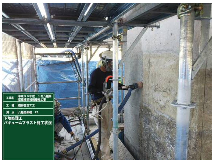
バキュームブラスト施工状況
