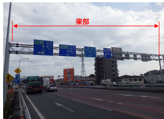
写真-2 撤去前（上り線東京方面を望む）
