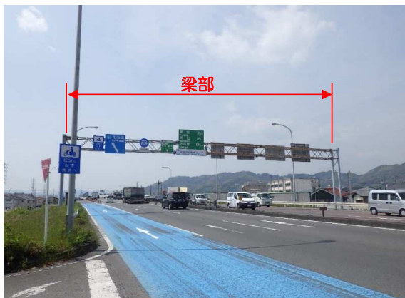
写真-1 撤去前（下り線名古屋方面を望む）
