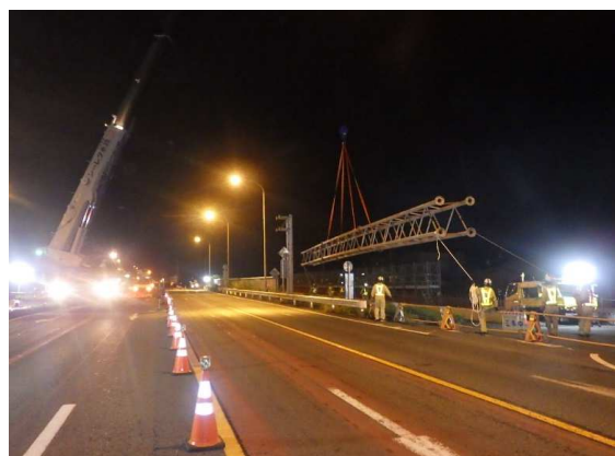
写真-6 門柱梁撤去状況
