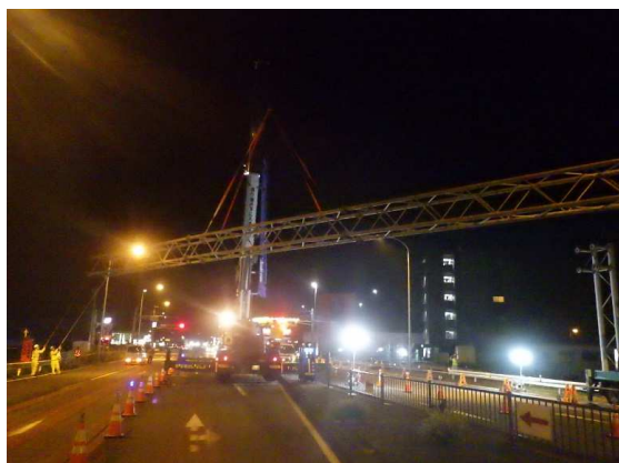
写真-5 門柱梁撤去状況
