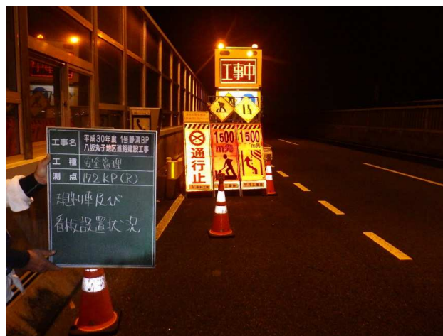
写真-4 規制車配置（非常駐車帯）
