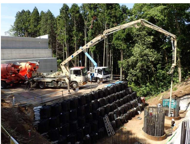
【ステップ3 深礎杭前列施工状況】
