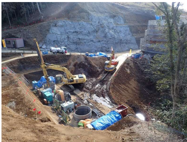
【ステップ1 深礎杭後列施工状況】
