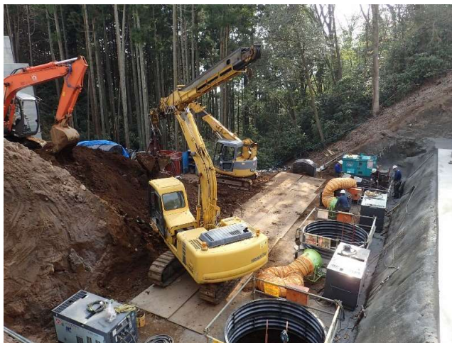
【ステップ2 深礎杭前列施工状況】
