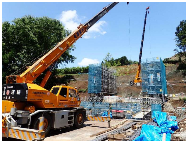
【A1橋台とL型擁壁の並行作業】
