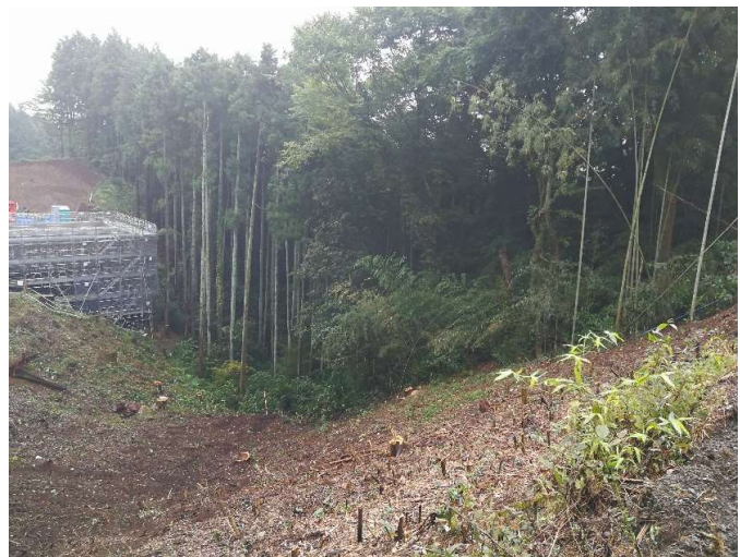
【着手前現況写真】 A1橋台側からA2橋台側を望む
