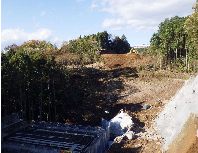
【着手前現況写真】 A2橋台側からA1橋台側を望む
