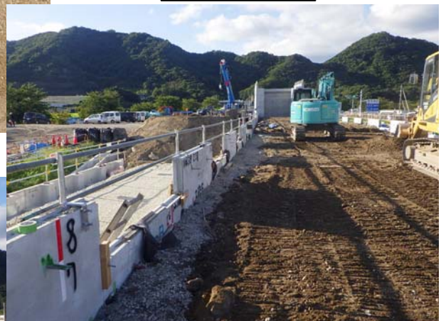
手摺設置状況
