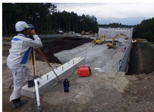
壁面材の鉛直度測定状況
