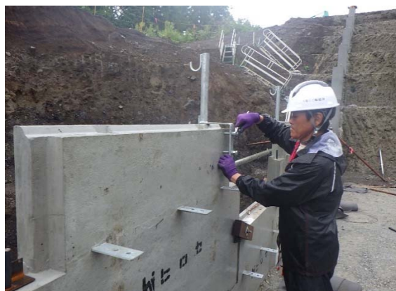
専用取付金具の取付状況
