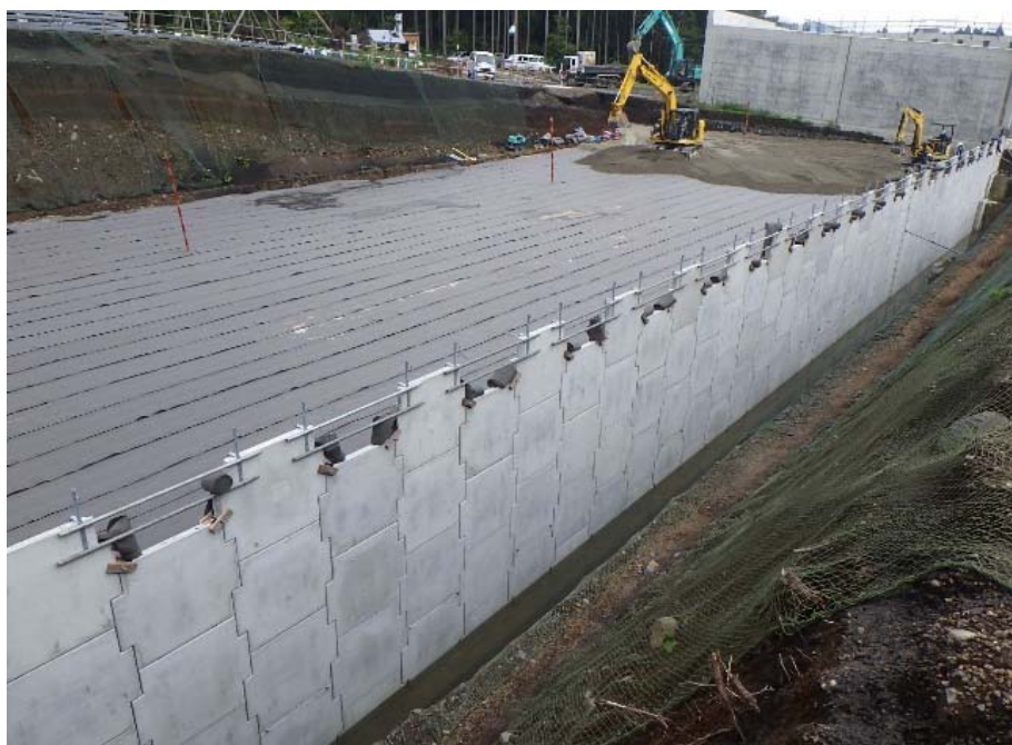
墜落防止用手摺りの設置状況
