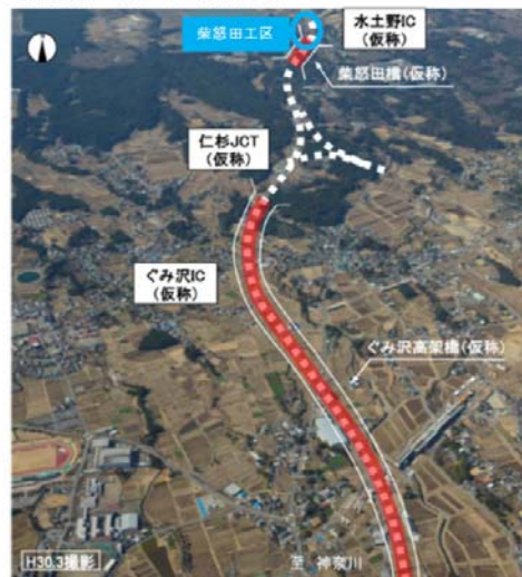
■御殿場バイパス (西区間)
