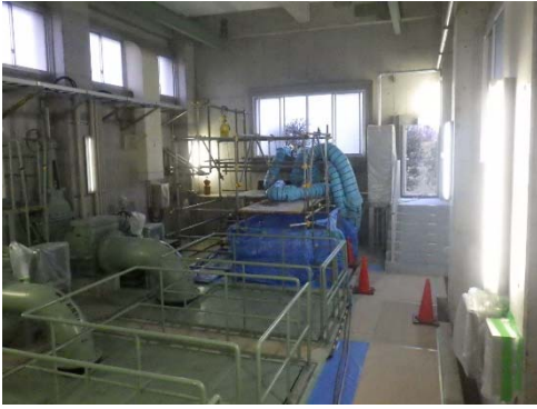
計器類の養生
