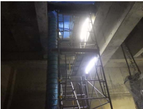
昇降設備の設置
