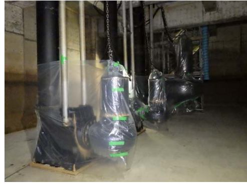
機械類の養生
