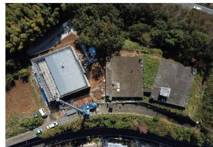
配水池組立中
