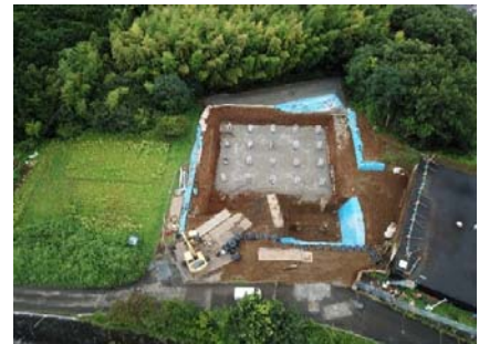
③工区施工中
