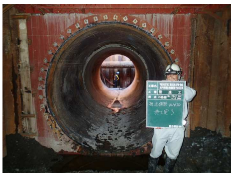
写 2. 推進施工完了
