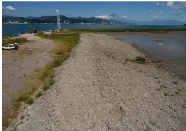
図2-2. 着手前捨土場所写真
