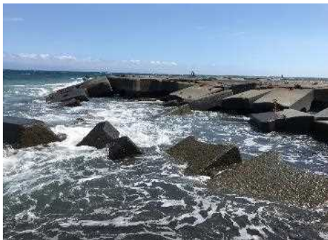
仮設消波設置前
