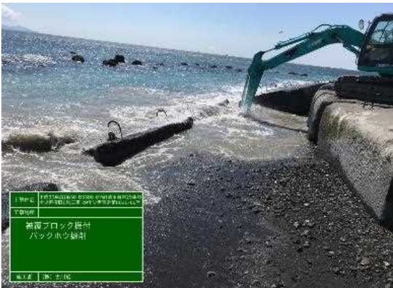
被覆ブロック据付前掘削
