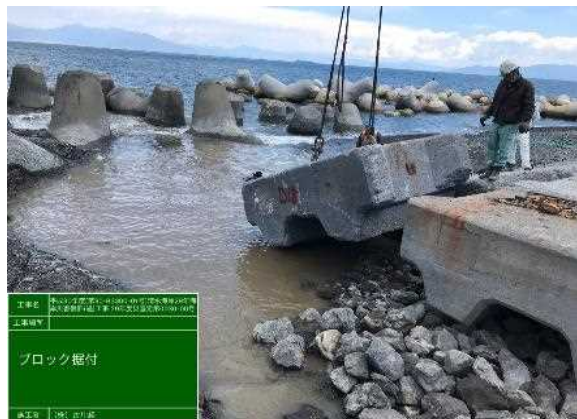
被覆ブロック据付
