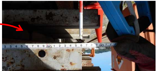
*本来9850mmの型枠が9860mmで10mm寸法が長い
