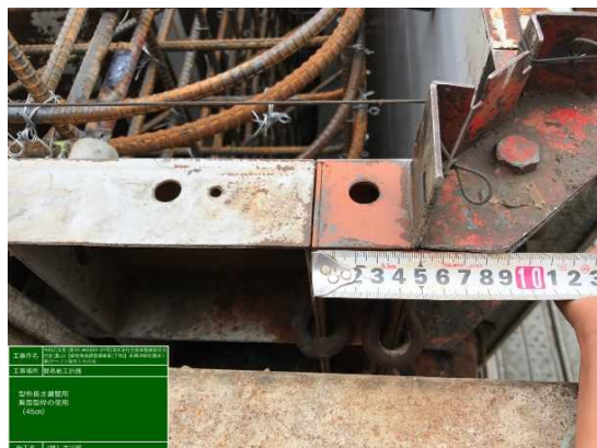
— 特注型枠設置状況 —
