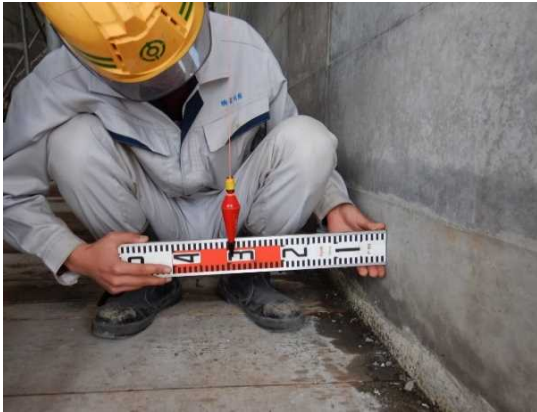
— 下げ振りによる鉛直性確認 —
