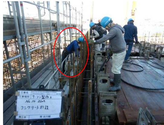
— 打設時の専属通り確認作業員 —
