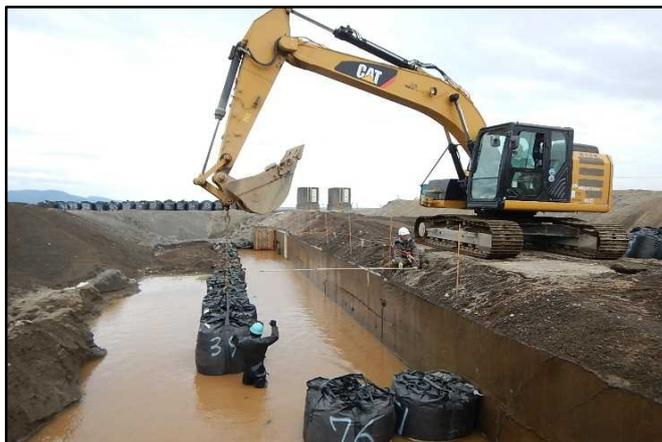
大型土のう据付状況(2段目)
