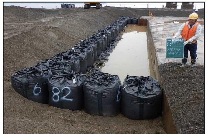
大型土のう据付完了(3段積)
