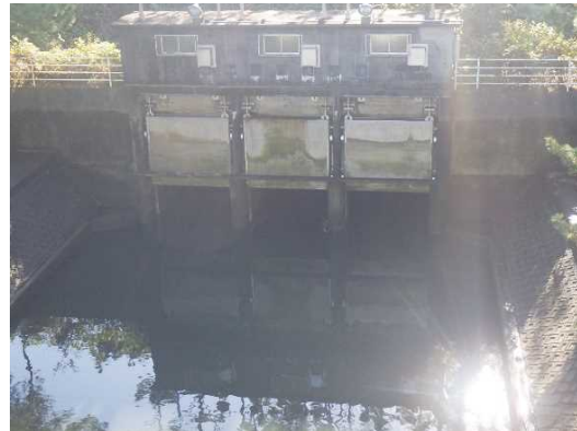
排砂水門（右側函体施工）
