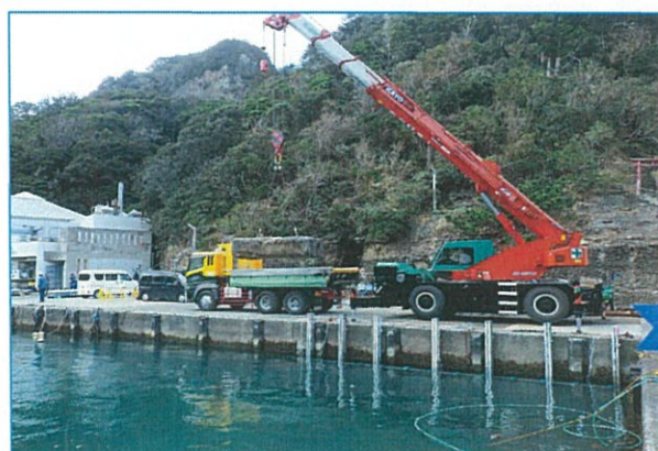
<写真3>方塊設置状況写真
