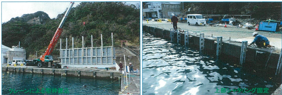
＜写真4＞型枠組立状況写真
