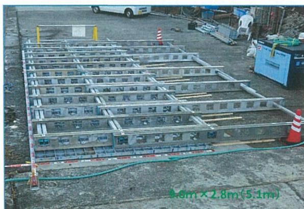
<写真2>型枠写真
