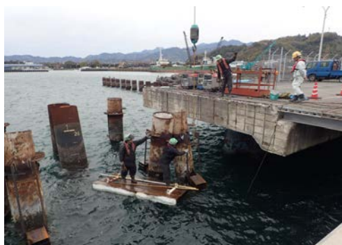
吊下げ式ブラケット設置状況
