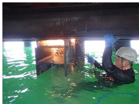
脚部切断状況
