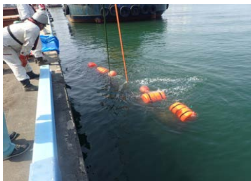
8m大引材(400H)引抜き状況
