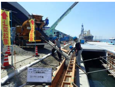
土留護岸上部工製作
