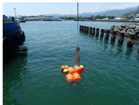
12m大引材(400H)引抜き状況
