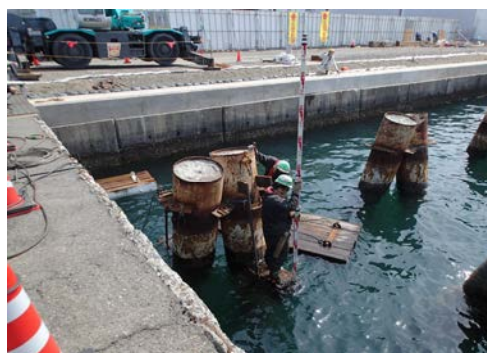
吊下げ式ブラケット設置状況
