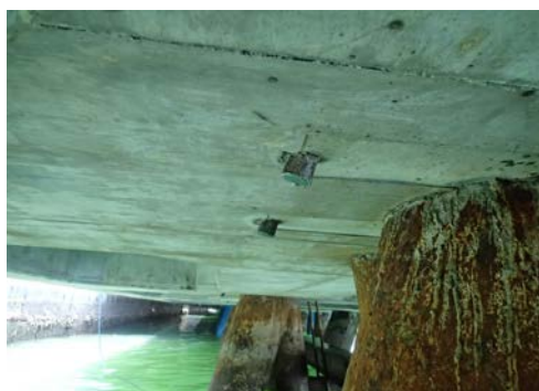
丸鋼(吊筋)切断
