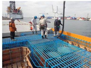
梁部コンクリート打設
