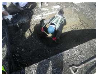
人力掘削状況
