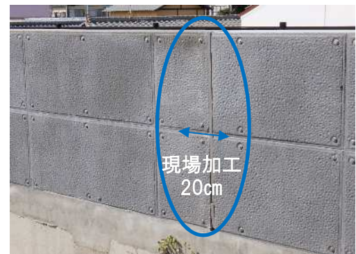
5m毎の目地割付をした他工区の波返し
