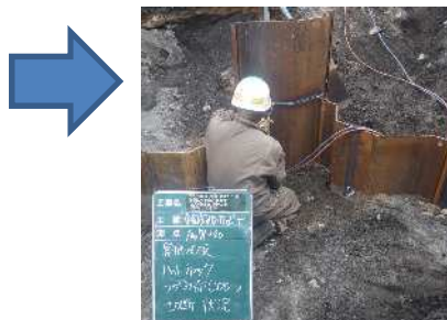
打設後、掴み代500mm 酸素切断状況
