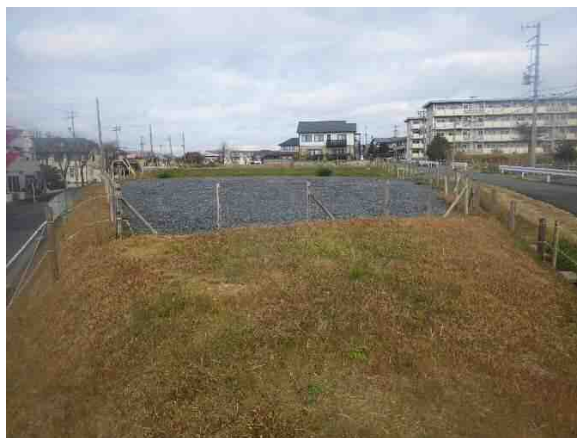
用地全景(南側より北側を望む)
