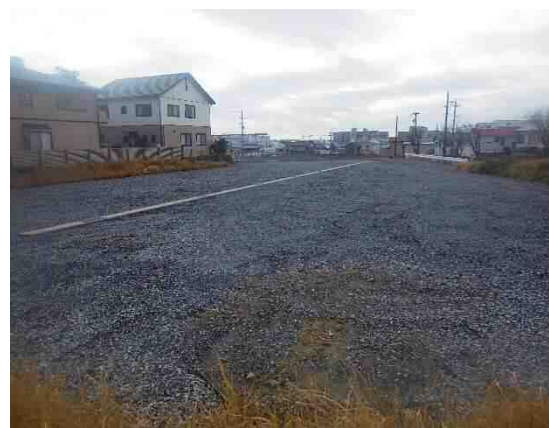
用地全景(北側より南側を望む)
