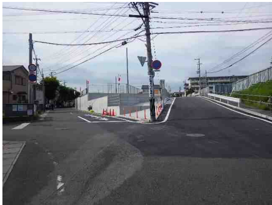
完成（南側より北側を望む）
