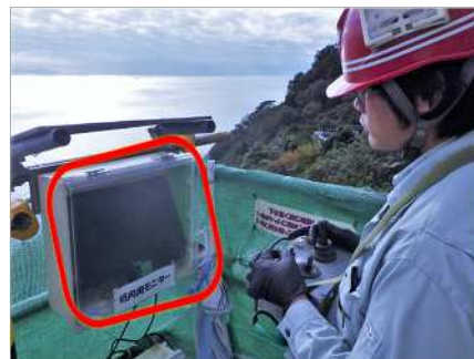
〈写真4〉クレーンオペレーターと確認用モニター
