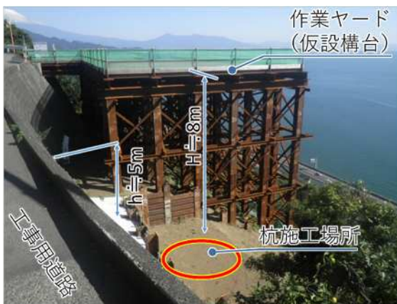
〈写真1〉SA7 杭施工場所全景
