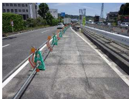
舗装版切断完了
