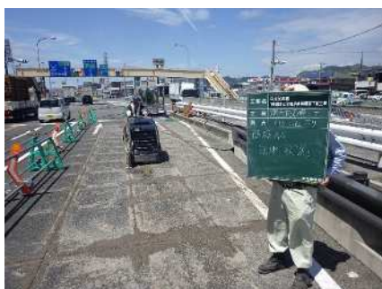
舗装版切断状況
