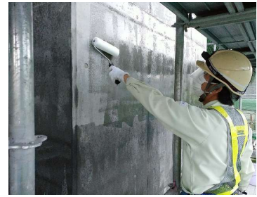
図9 クラックセイバー塗布状況
