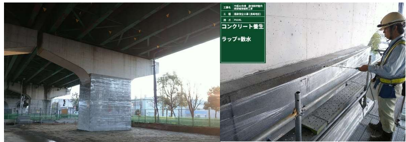
図10 ラップ設置・散水状況
