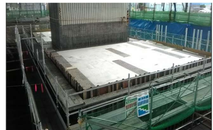
図5 うるおんマット敷設状況
