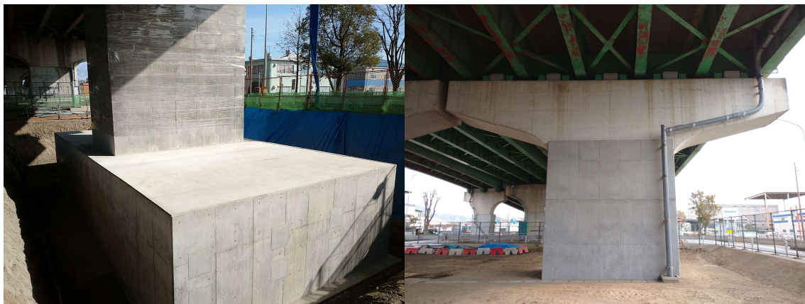
図11 フーチング・橋脚コンクリート巻き立て 完成写真
