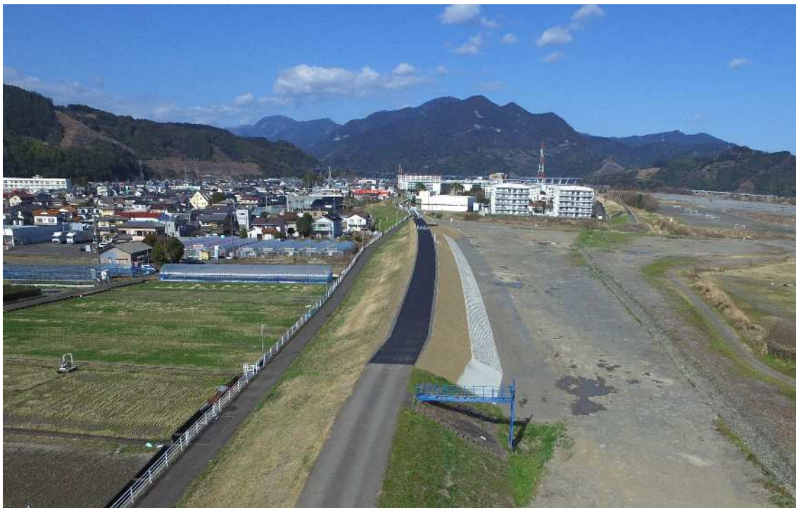
写真 7 : 完成全景(ドローン撮影)
