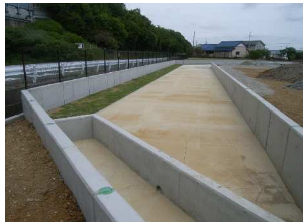
誘発目地設置完了
