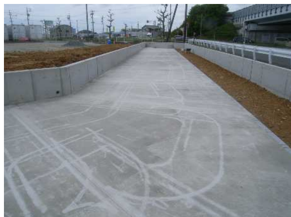
土間カッター施工完了
