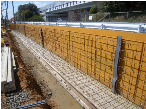
誘発目地材設置
