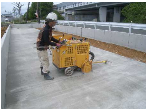
土間カッター施工状況
