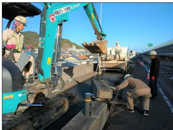
写真-4 置き基礎撤去
