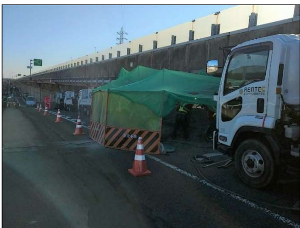
写真-6 研り作業時の飛散養生
