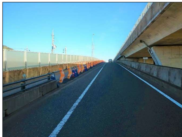
写真-5 撤去・仮舗装完了
