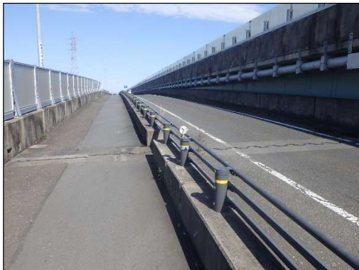
写真-1 施工箇所
