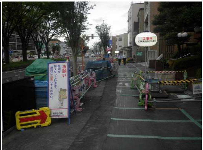
作業終了時の道路開放
