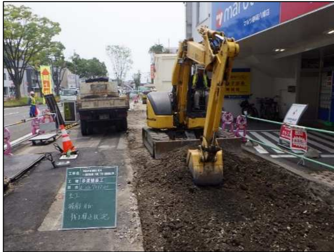
歩道を半分に分けて施工
