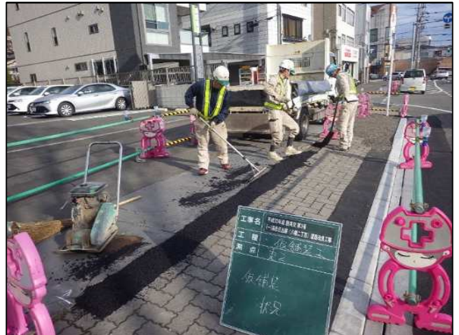
着手前の段差処理
