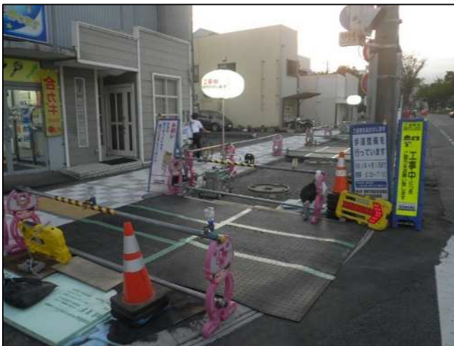
作業終了時の道路開放
