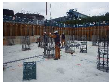
施工状況 (鉄筋かご先行)
