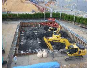
掘削状況(全景)
