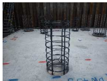
施工状況 (鉄筋かご先行)
