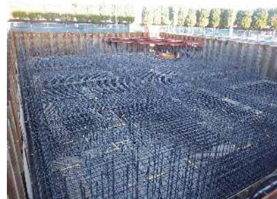
施工状況 (鉄筋かご先行)
