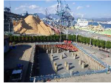
掘削完了(全景)
