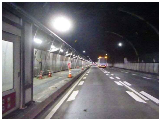
写真-3 既設支柱壁撤去完了状況
