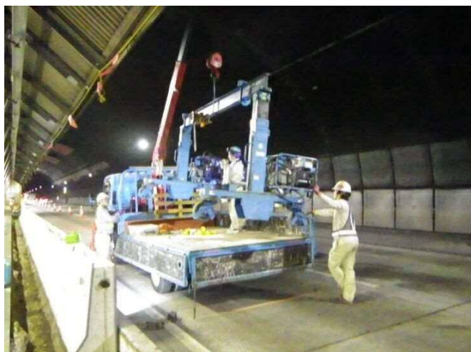
写真-5 据付機械搬入状況
