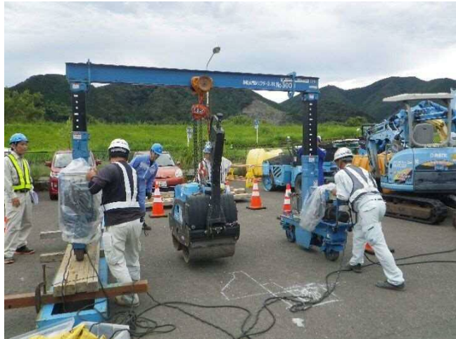
写真-4 事前施工確認状況
