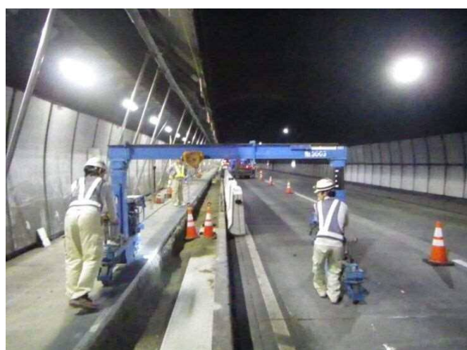
写真-8 リフタークレーン縦断方向人力移動状況
