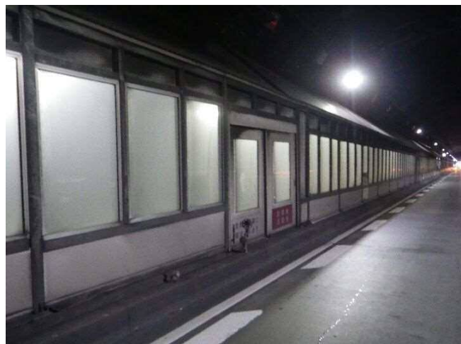
写真-2 着手前現場状況
