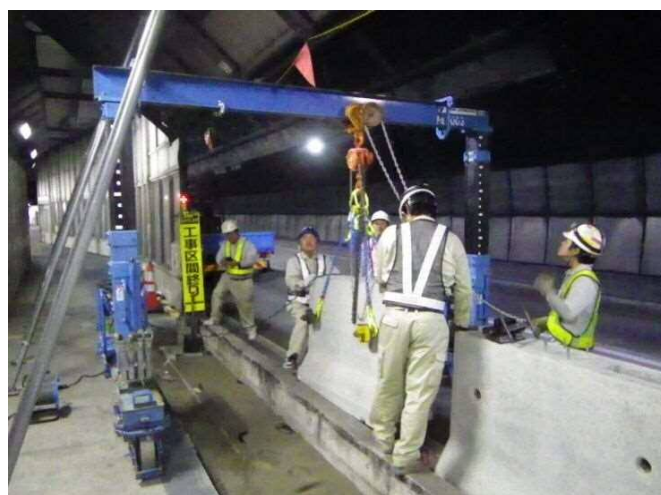
写真-6 ブロック吊上げ横移動状況
