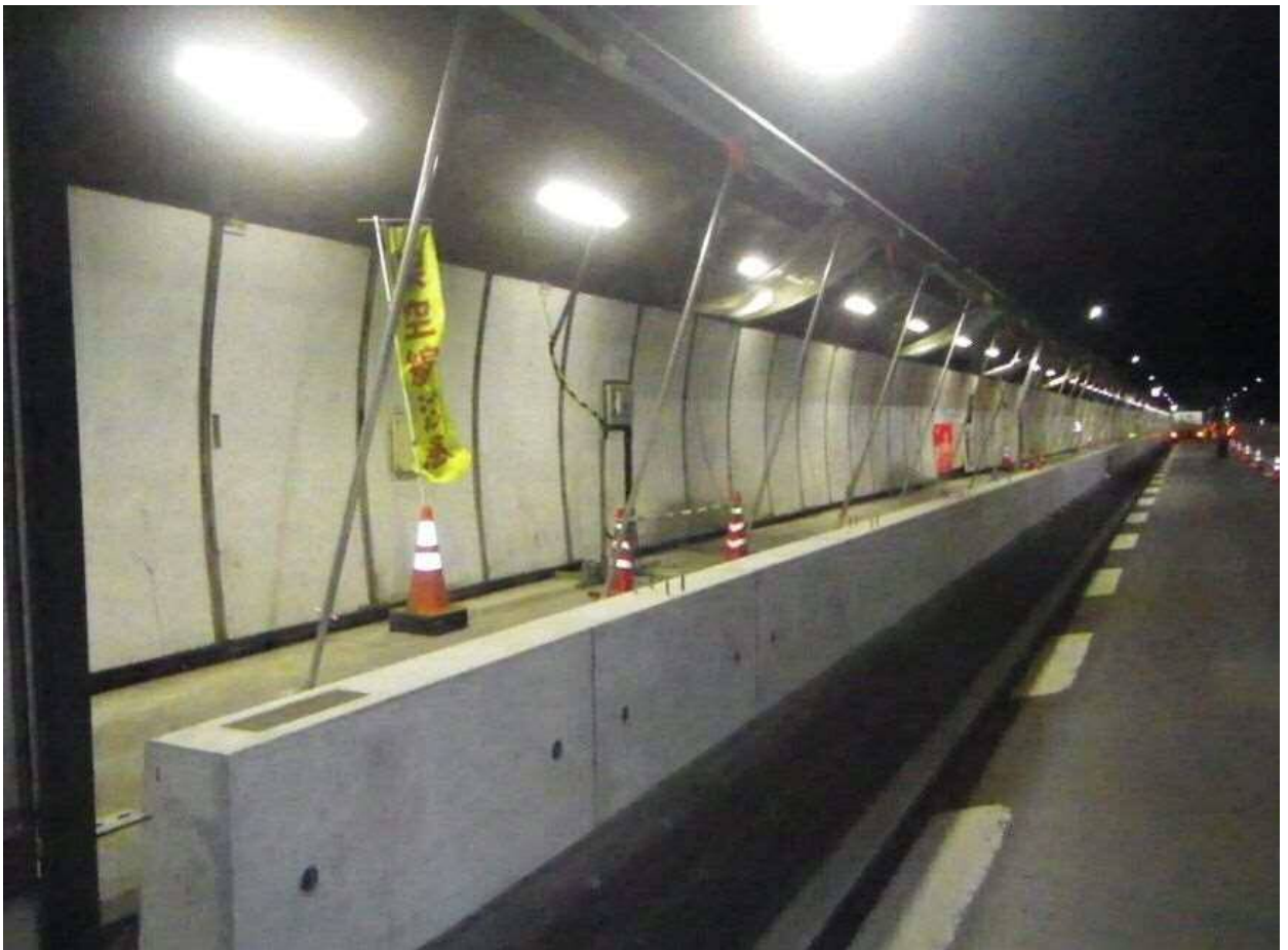
プレキャストブロック設置完了
