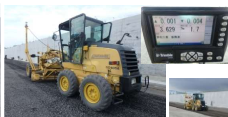
写真-3 MCグレーダー-敷均し
