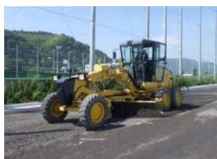
写真-1 グレーダー-敷均し
