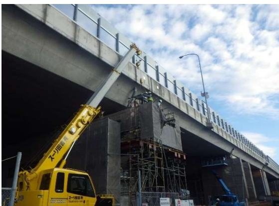
荷揚げ場設置
