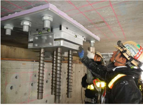
設置完了（水平確認）
