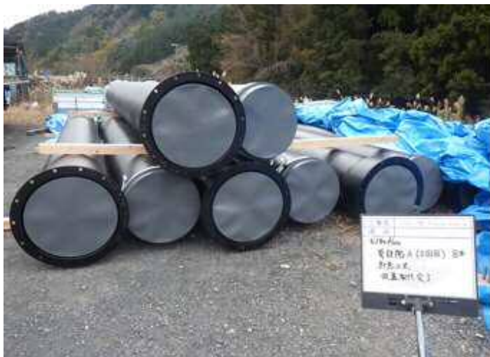
φ 600送水管への仮蓋設置写真
