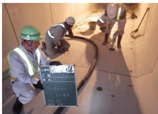
写真-5 モルタル注入状況
