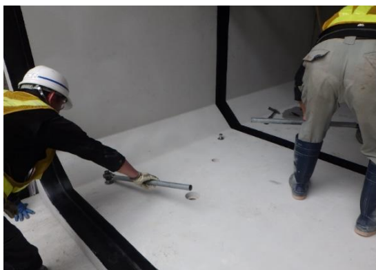
写真-4 高さ調整状況
