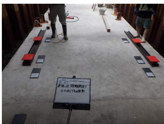
写真-3 スライドベース設置状況
