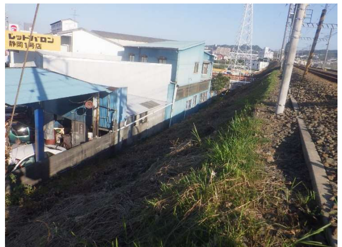
着手前：下り線側
