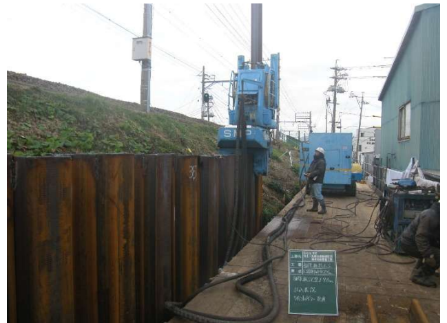
鋼矢板挿入状況 (下り線側) (写真-6)
