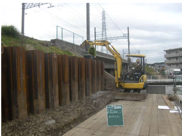
バックホウ作業状況 (写真-7)
