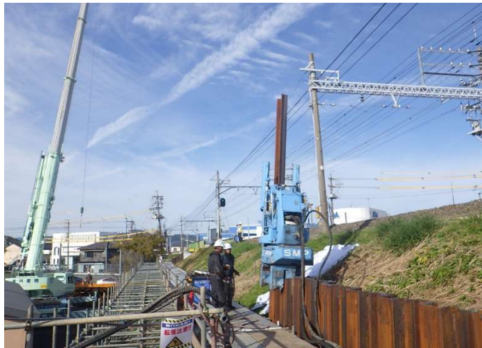
鋼矢板挿入状況
