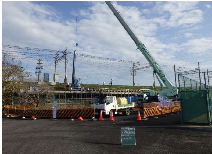
隣接地より鋼矢板搬入、設置状況 50 t ラフタークレーン使用
