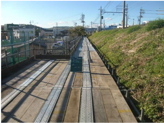
単管使用の作業床設置状況 (写真-3)
