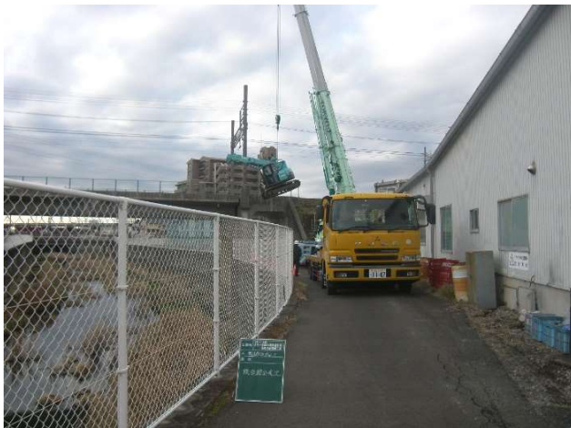
小型クローラークレーン吊上げ状況 50tラフタークレーン使用 (写真-5)
