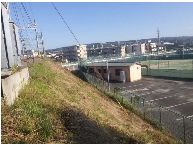
着手前：上り線側
