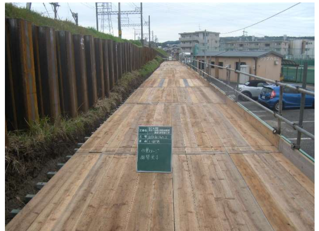
TSサポート使用の作業床設置状況 (写真-4)
