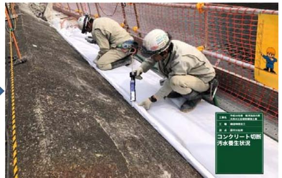
②シートと既設護岸の隙間をコーキングで埋め、汚水の漏水を防ぐ。
