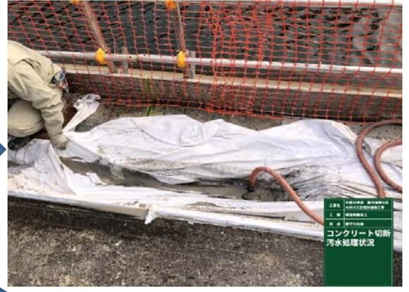
④下流側へ水中ポンプを設置し、汚水を回収する。
