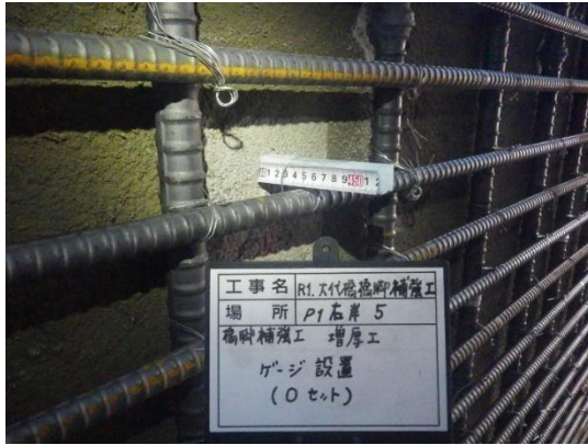
(不陸修正面に厚さゲージを設置)
