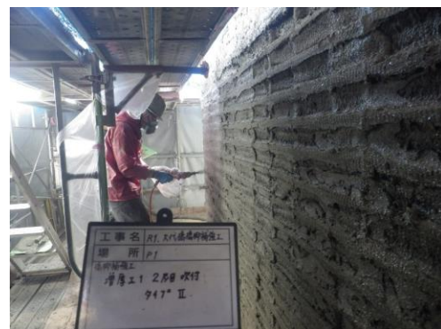
(吹付施工状況)
