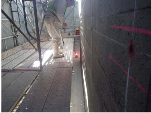
(離隔測定状況)
