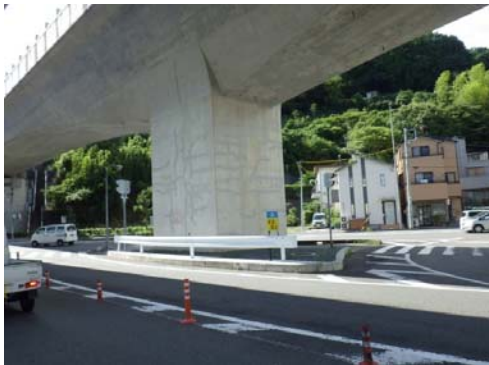
南側車道（片側交互通行）
