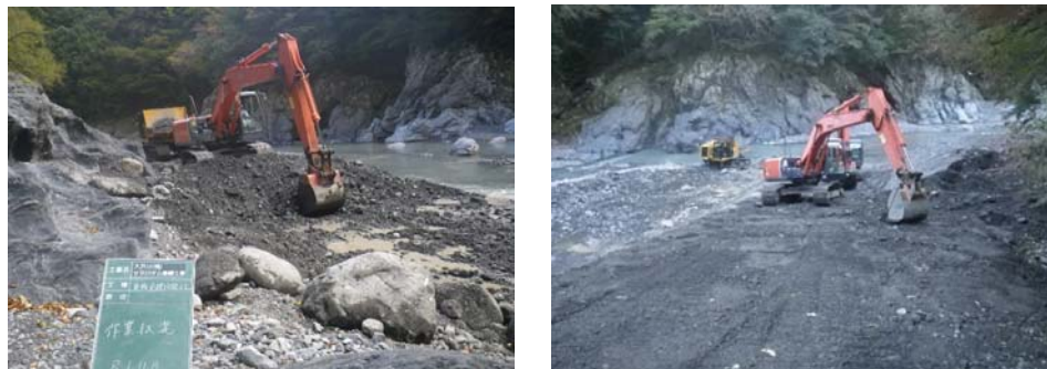
重機退避用盛土造成状況
