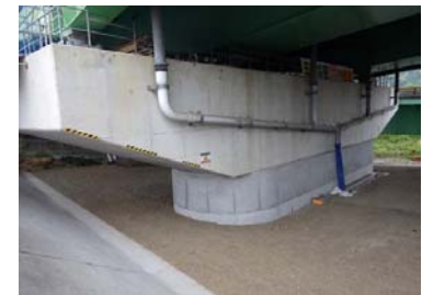
橋脚コンクリート巻立て完了
