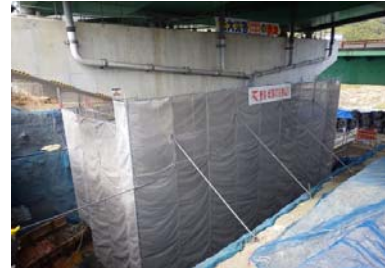
橋脚コンクリート巻立て完了
