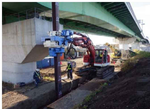
親杭(H-300)打設状況 (CHV-200、0.8m3級バックホウ使用)
