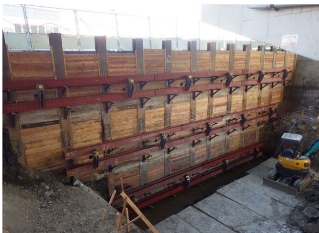
P117橋脚 土留・仮締切工 施工完了
