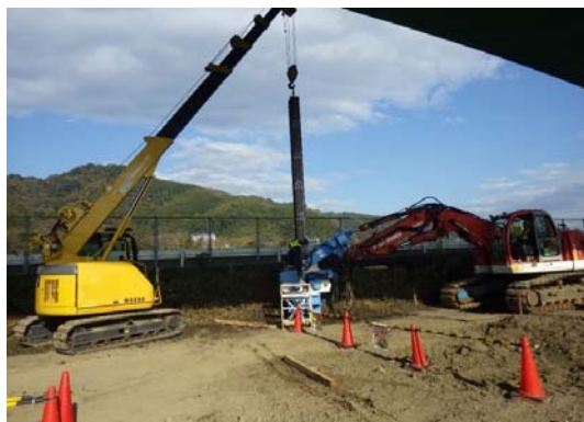
親杭(H-300)吊込み、チャッキング状況 (4.9tクローラークレーン使用)
