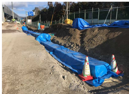
養生の様子(2重養生)
