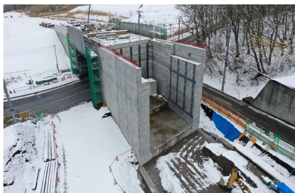
擁壁完成全景
