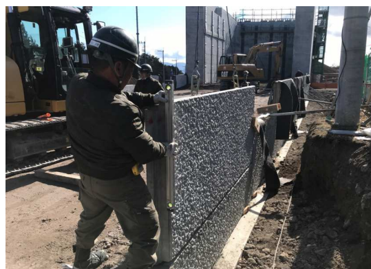
パネルの傾斜確認
