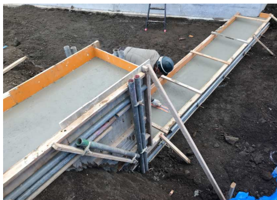
打設後天端均しの状況
