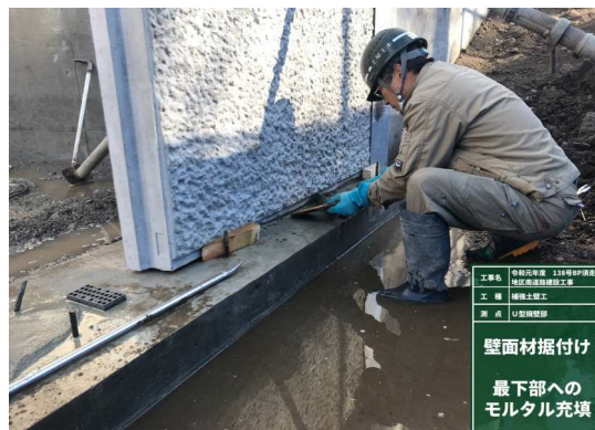
最下段パネルはモルタルを充填する
