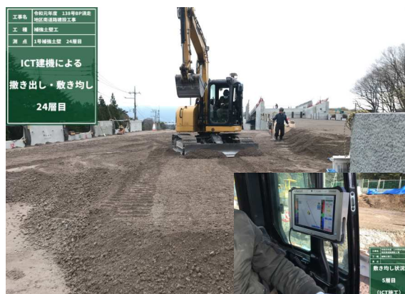
ICT敷均し( 0.25\text{m}^3\text{BH} )
