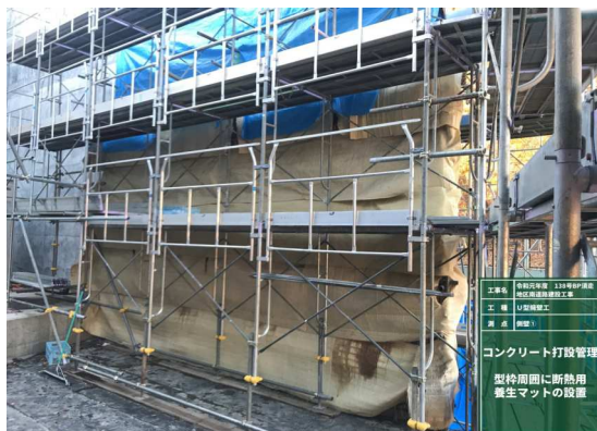
型枠外周の養生の様子
