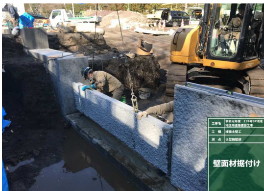
パネル据付状況
