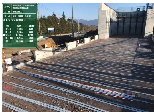
ストリップ設置状況
