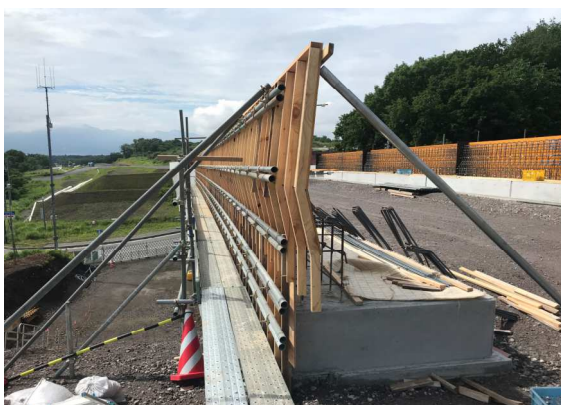
工場制作型枠の設置状況
