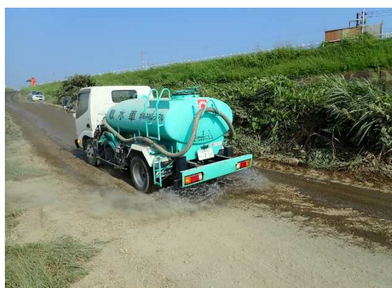
場内外の散水養生・清掃
