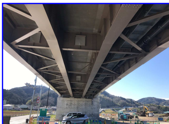
脱枠後の床版コンクリート
