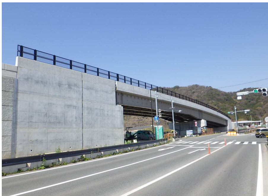
完 成（終点側より撮影）
