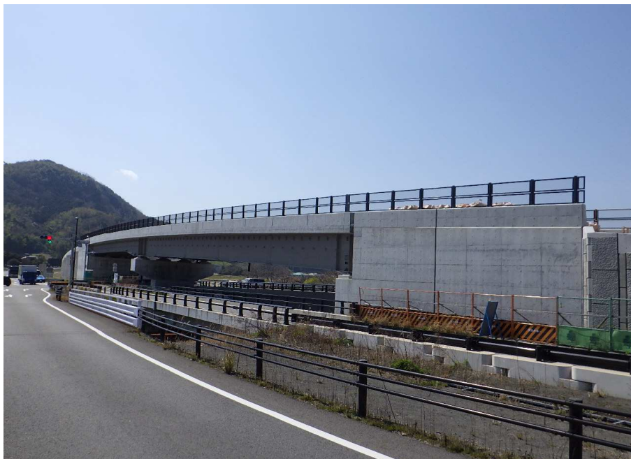
完 成（起点側より撮影）
