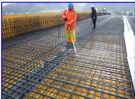
型枠清掃状況
