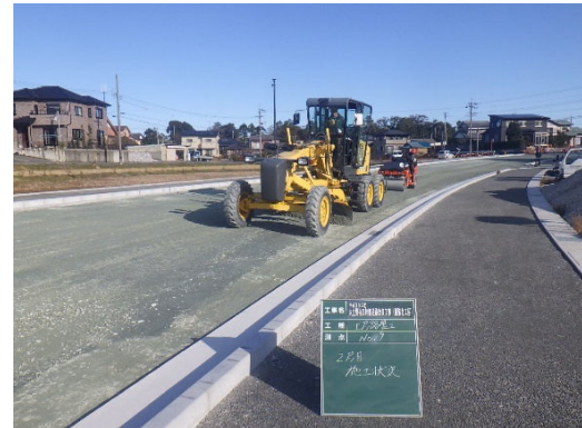
上層路盤施工狀況
