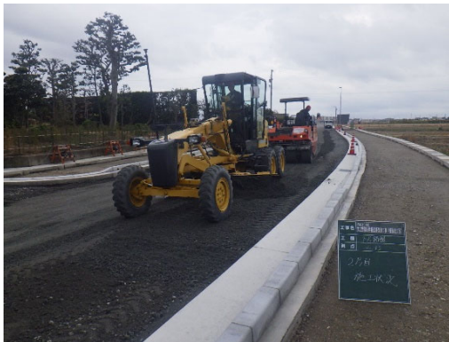
下層路盤施工狀況
