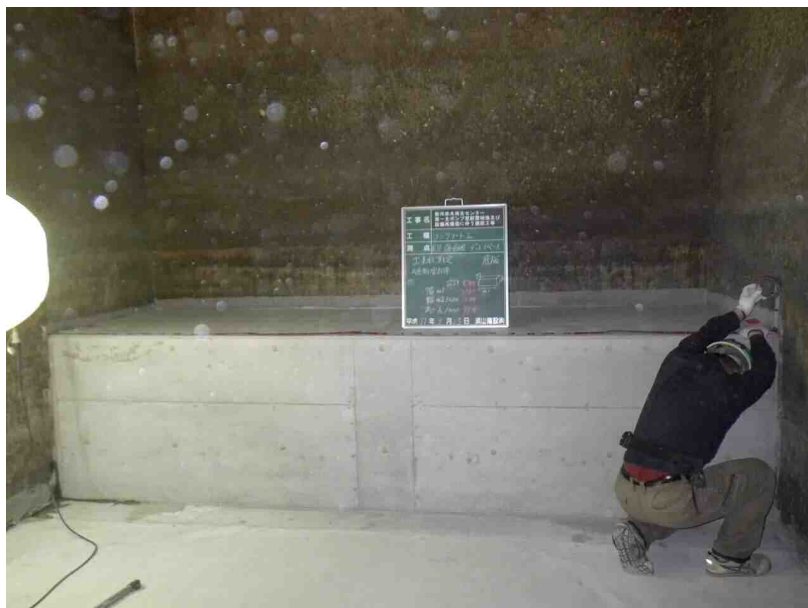
デッドスペース コンクリート打設完了
