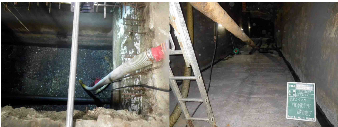
汚泥排水状況
