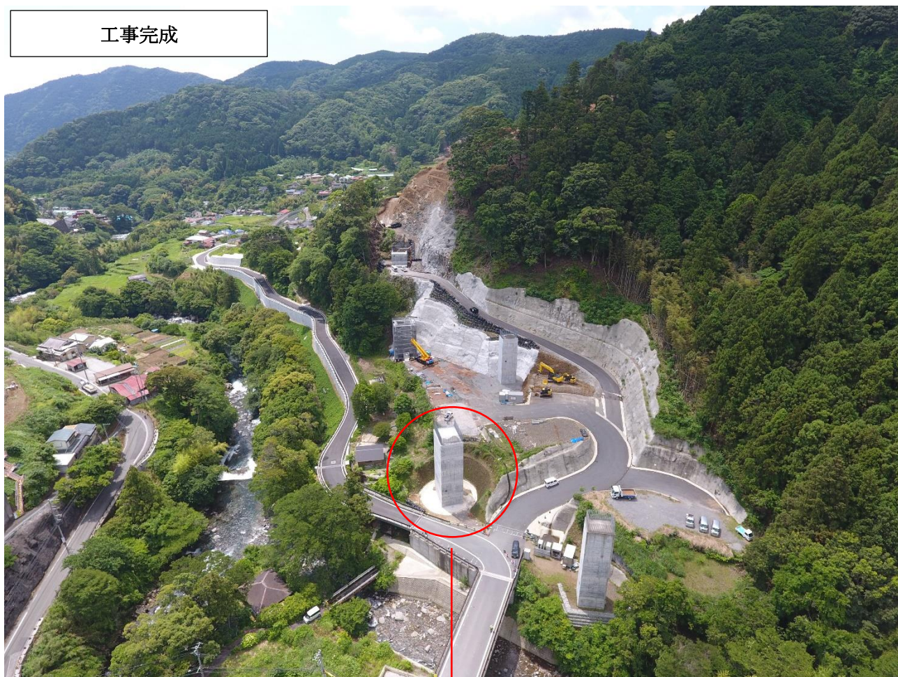
AP4 橋脚完成
